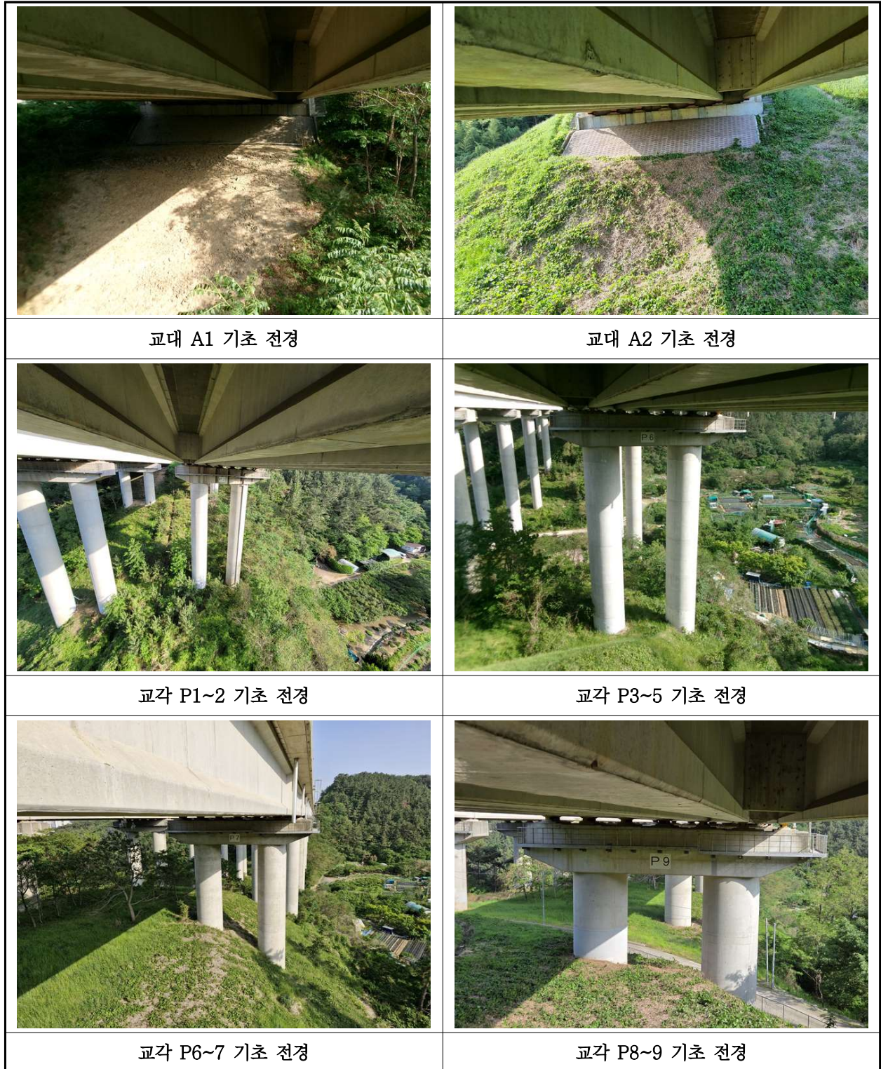
【사진 13.3.12】 기초 전경
