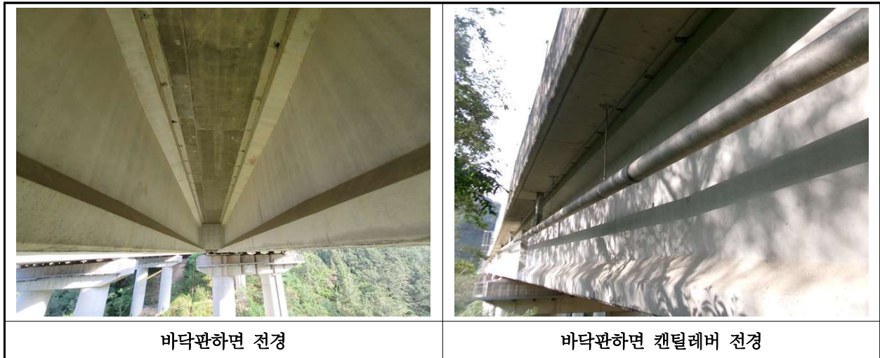
【사진 13.3.2】 바닥판하면 전경
