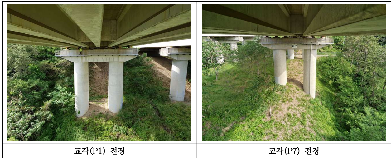
【사진 13.3.10】 교각 전경
