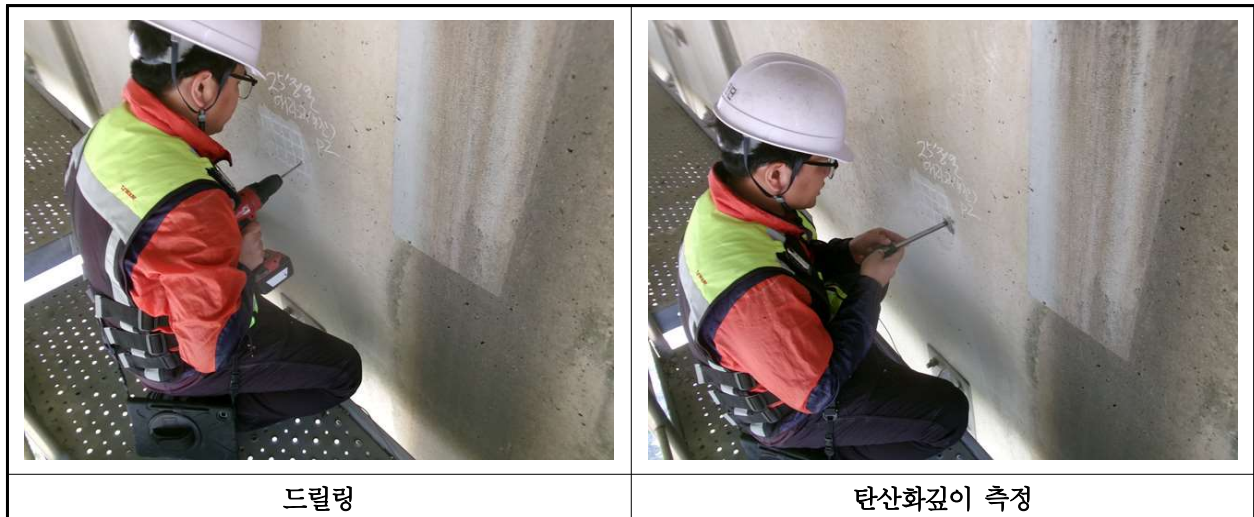
【사진 13.4.3】 탄산화 깊이 측정 현장사진
