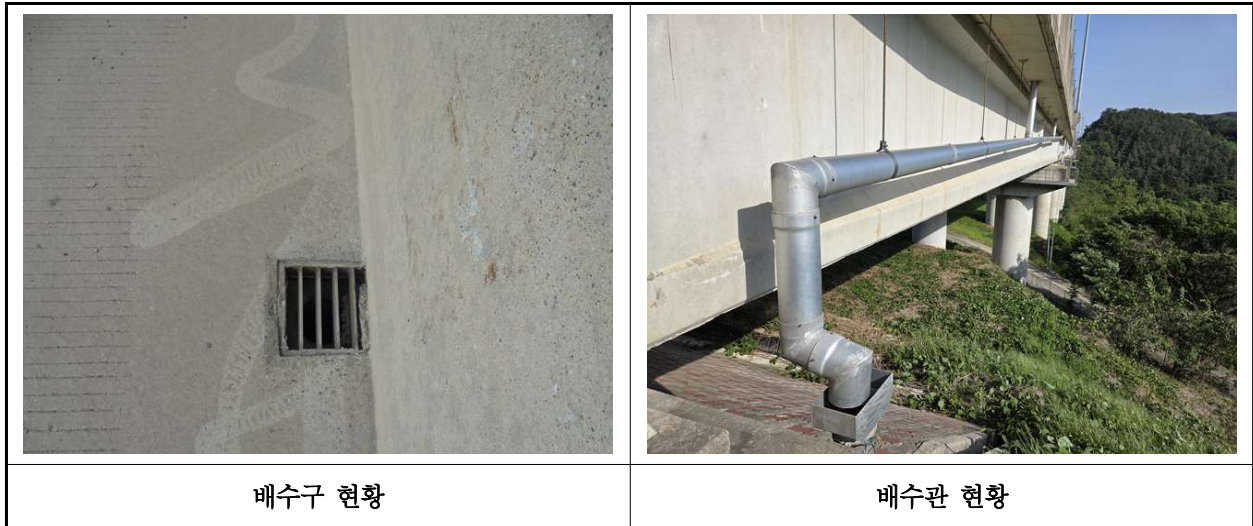
【사진 13.3.22】 배수시설 전경
