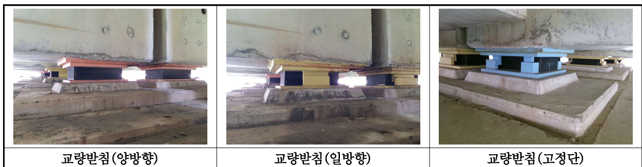
【사진 13.3.13】 교량받침 전경
