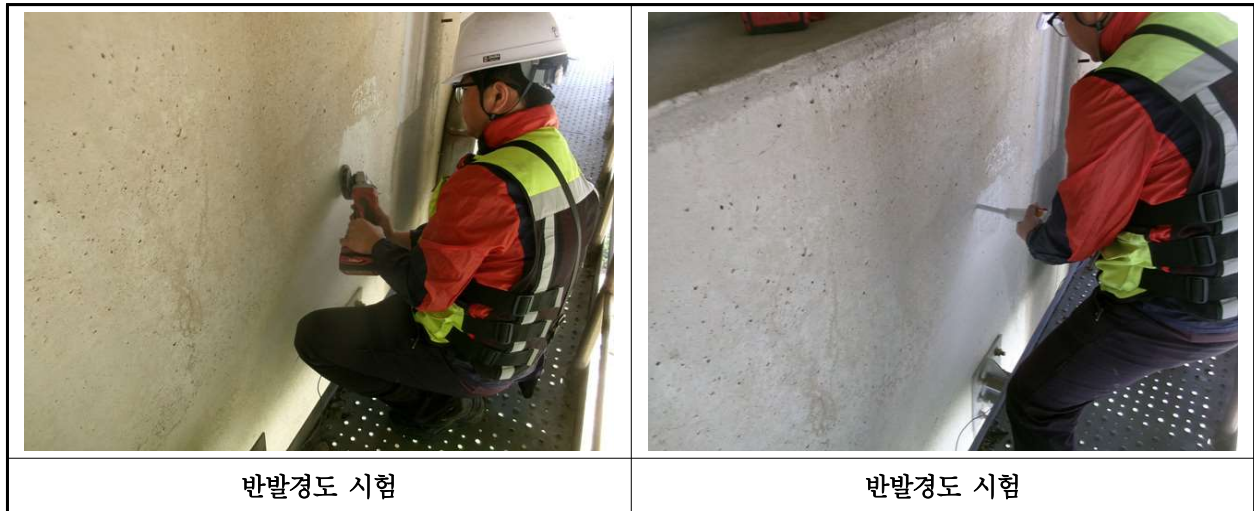
【사진 13.4.2】 반발경도시험 현장사진
