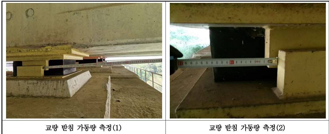
【사진 13.3.16】 교량받침 이동량 측정
